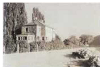
Abb. 3: Villa Demmer „Zur alten Engelmühle“, Beginn der Abtragung, 1973
