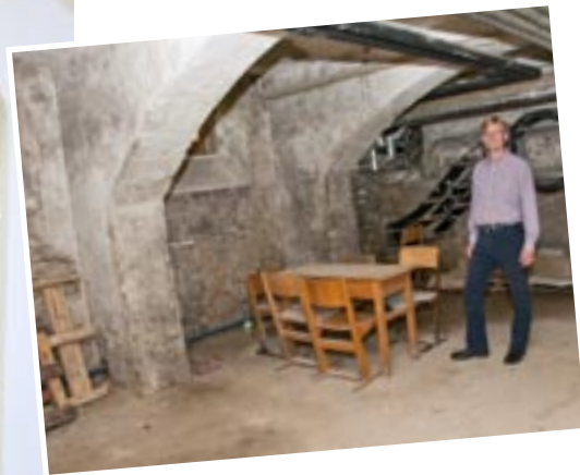
GGR Peter König zeigt den Zustand vor der Renovierung.
