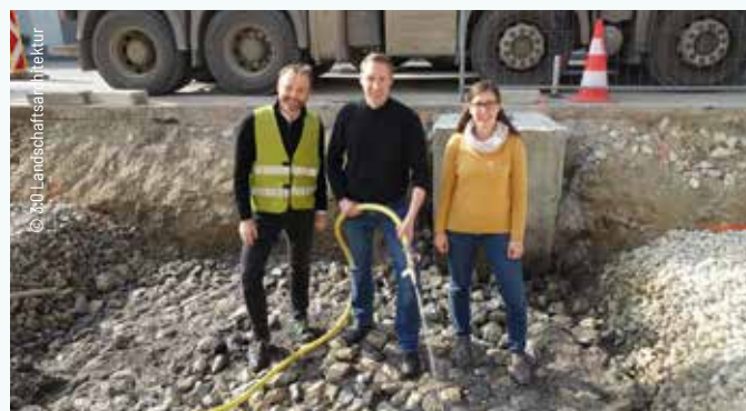
Einbau des Schwammkörpers unter dem Gehsteig vor der Sparkasse: GGR Dipl.-Ing. Franz Graßl (Mitte), rechts und links: DI Daniel Zimmermann und DI Marion Tatzber von 3:0 Landschaftsarchitekten
